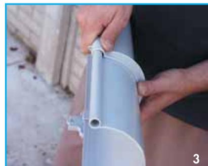
On peut assembler les profilés directement les uns aux autres simplement avec des jonctions ou en intercalant différents accessoires (voir détails sur le catalogue).
