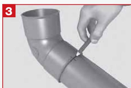
**3** Mesurer et repérer à l'aide d'un crayon gras ou feutre sur le bout mâle, la profondeur d'emboîtement.
