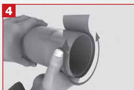
**4** Dépolir complètement les surfaces destinées à être mises en contact (bout mâle et emboîture) à l'aide de toile émeri fine, ou de papier de verre fin. L'usage de la râpe ou de la lame de scie à métaux est interdit pour cette opération. Si le tube est souillé (graisse, terre...), un essuyage est nécessaire avant le dépolissage.
