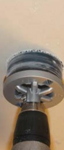
Percer un trou à la scie cloche du diamètre indiqué sur la notice de pose du spot. Ensuite faire sortir les fils d'alimentation.
