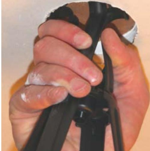
Pousser le RAMSPOT® jusqu'à placer les ergots de part et d'autre de la plaque de plâtre.
