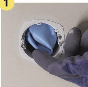
Mise en place du boîtier dans le faux-plafond
