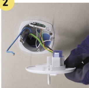
Câblage du socle et du micro module
