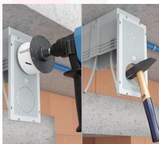
Diamètre d'encastrement 68 mm à enfoncer ; diamètre jusqu'à 86 mm à fraisier
