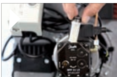
Echanger la cartouche filtre de la pompe (• 2).
