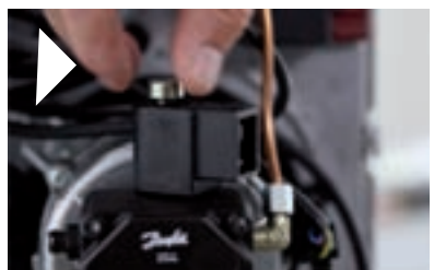
Remplacer la bobine de la pompe (• 4).
