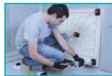
3 DISPOSER LES PIEDS ET INJECTER LA RÉSINE
