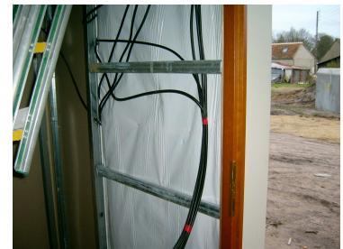
**Domaine d'utilisation:** Système de fixation des fourrures de type F47 ou autres pour plaques de plâtre ( DTU 25.41 norme NF P 72203 ) garantissant l'étanchéité à l'air des murs, dans le cadre des obligations du Cahier des Prescriptions Techniques 3560, des Réglementations Thermiques 2005 à 2020; labels: BBC, THPE, BEPOS, etc. définis par le CNDB et le CSTB, et ceci pour tous les types de bâtiments.
