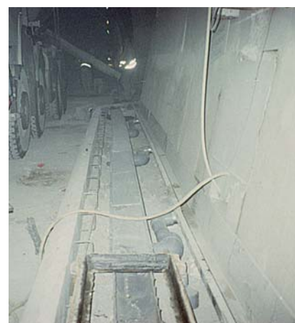
Mise en œuvre du FIRST PLAST dans le tunnel du Mont Blanc
